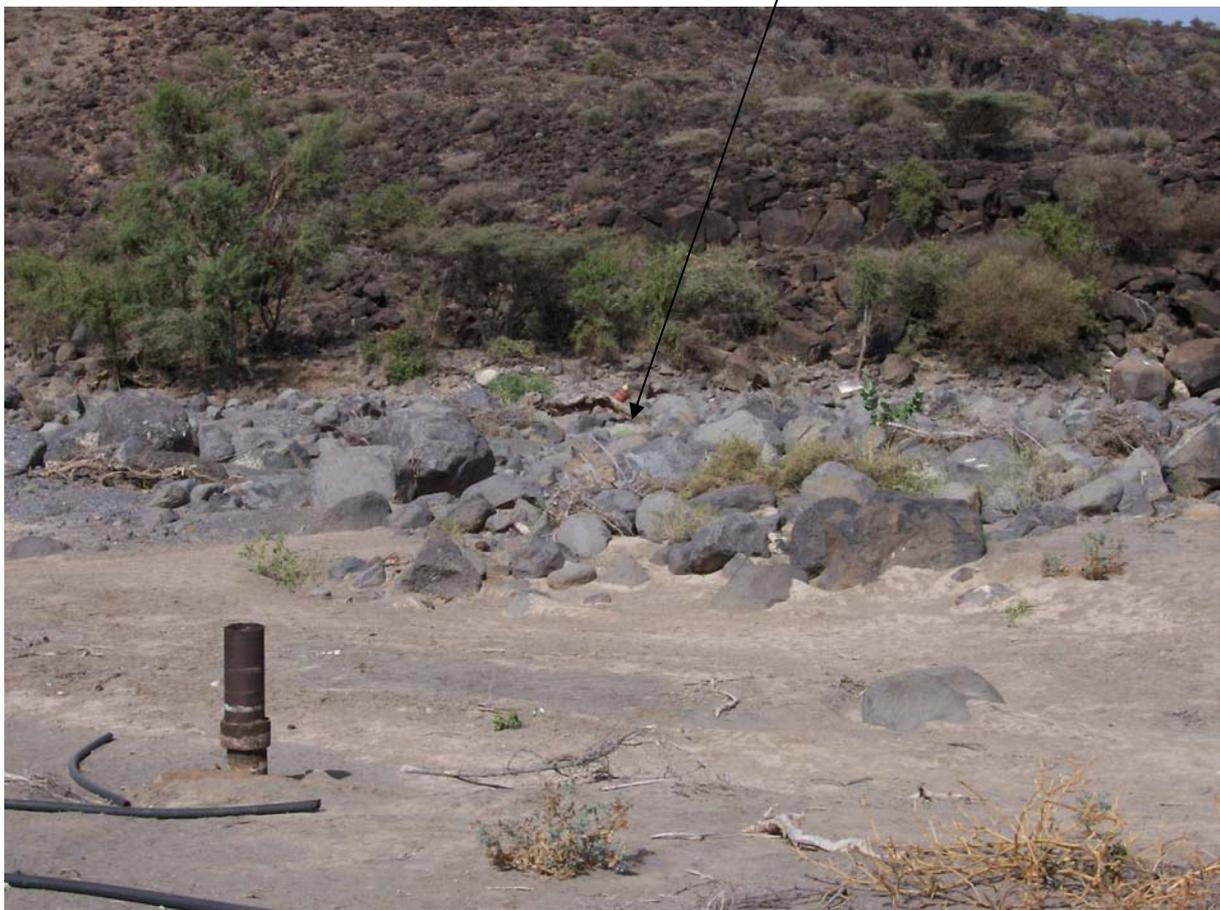
C'est l'exemple d'un forage détruit par l'oued. En effet le forage de Boli, localité de Randa, est actuellement hors service pour la simple raison qu'il a été détruit par l'oued Boli. Et comme la photo le montre l'équipement se trouve toujours sur le forage (pompe immergée, tuyau galvanisé).
