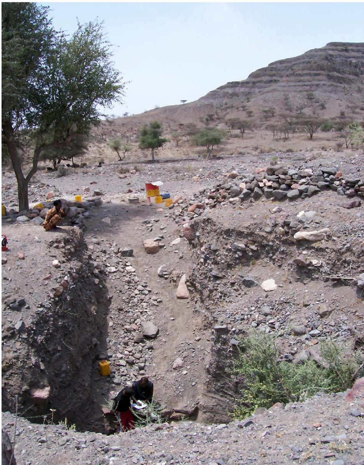
C'est le puit de Magale 3, de 11 mètres de profondeur, non protégé. Il est situé dans le lit de l'oued. Construit sur des alluvions il risque de s'effondrer d'un jour à l'autre laissant les populations et leurs bétails sans eau.
